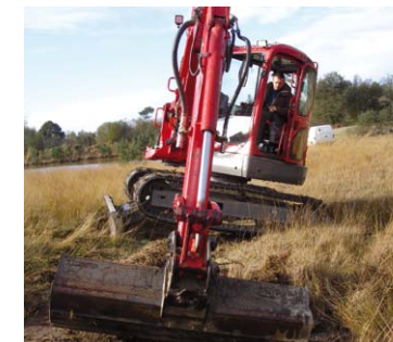
Réhabilitation de la décharge de l'ancienne tannerie de Barjols (83) à gauche et, à droite, restauration d'un milieu tourbeux à Monteneuf (56) par la technique d'étrépage 1 .
