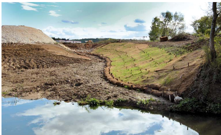
Confortement des berges de la Braune RN 106 (Gard)
